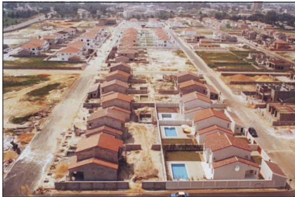
La société MSF apporte une solution aux problèmes majeurs d'infrastructure et d'assainissement, à Pointe-Noire.
